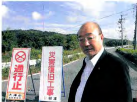
▲台風18号による災害復旧工事現場にて
