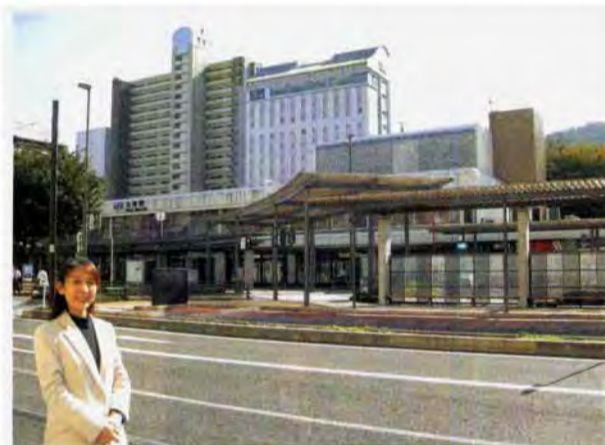
▲整備方向が検討される大津駅舎
