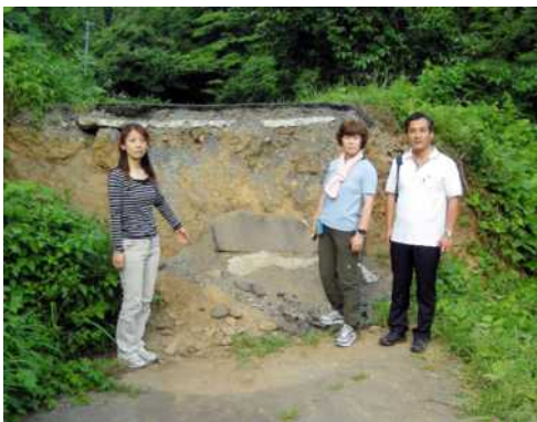
↑井戸沢断層で。地震で断層がずれ、2メートル近く道路が崩れ落ちています。
