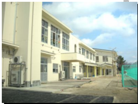
3月に完成した大津市比叡平幼保一体化施設「やまのこひろば」→
